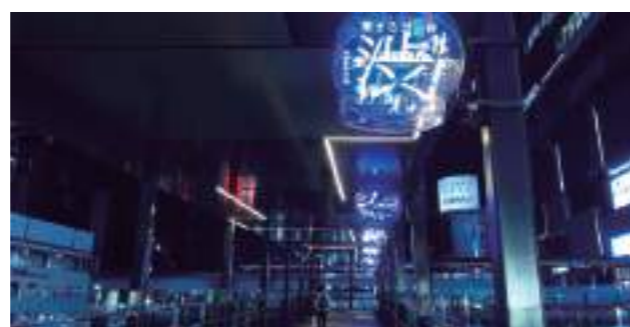
西口地上広場:道玄坂仮設デッキ・道玄坂連絡デッキ
